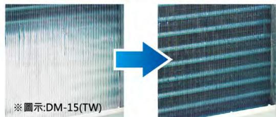
偵測器偵測到蒸發器有結霜的情形時立即開起自動除霜功能。
